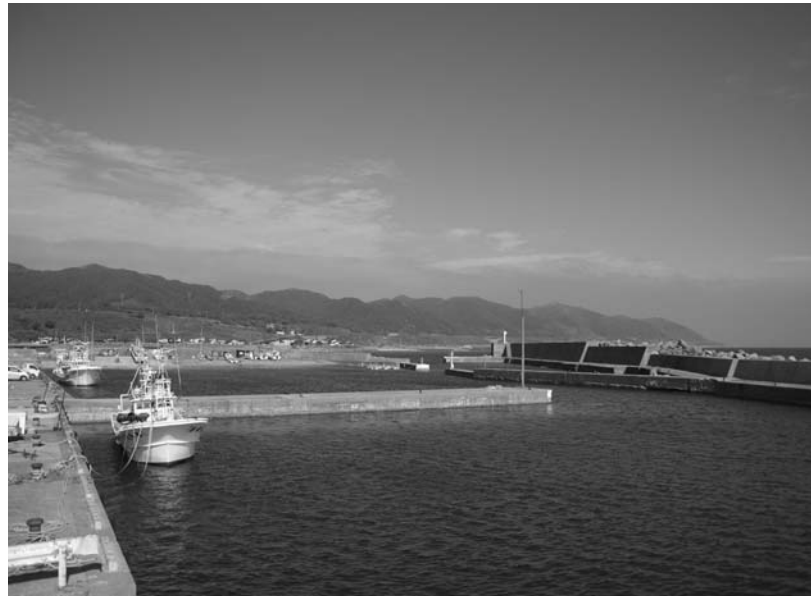
海水交換型防波堤の導入が期待される大沢漁港
