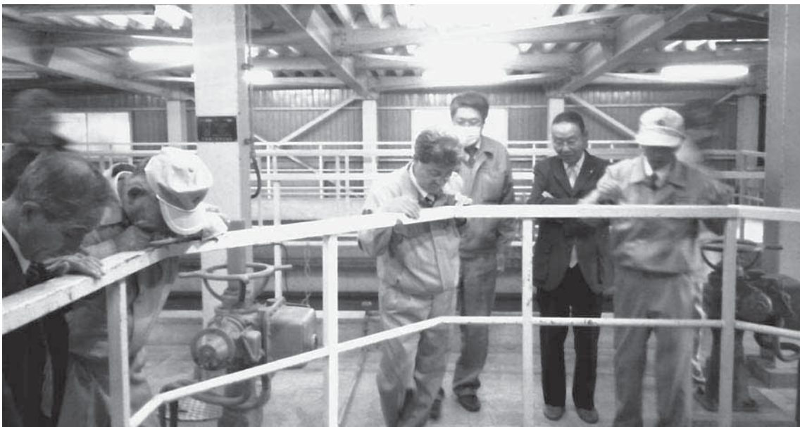
松前浄水場（字豊岡）現地視察の様子
