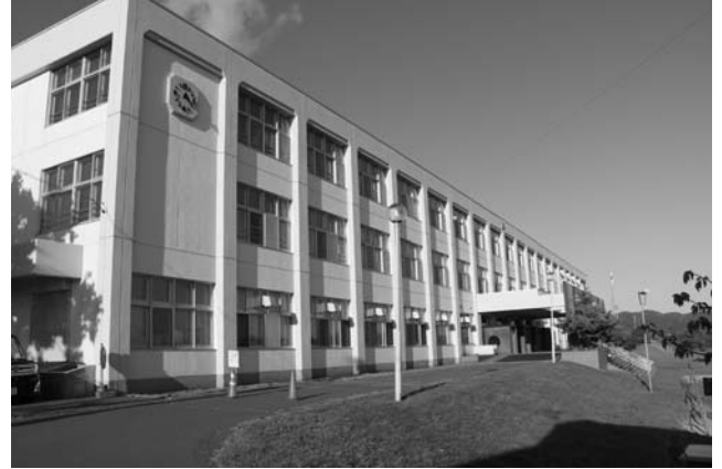
松城小学校の外壁工事を行いました
